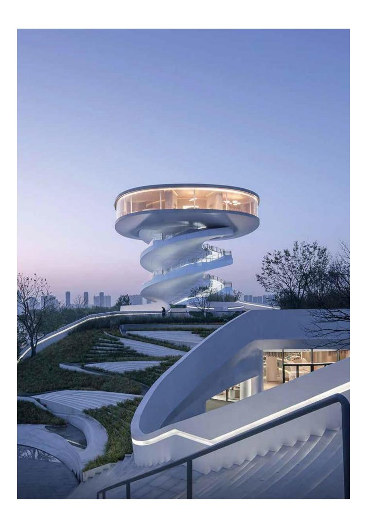
连接处被整合在一起,这样整个结构可以被分成多个独立的系统。在每个区域安装接头,以解决与安装大型双曲型单层钢结构相关的技术问题。
